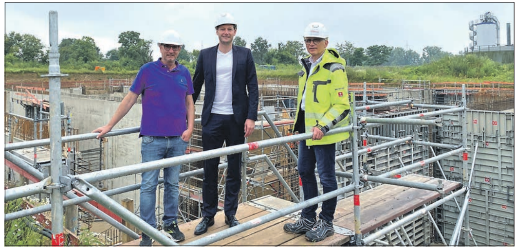
Markus Philipp (Leitung Tiefbau), Oberbürgermeister Alexander Hetjes und Martin Schmidt-Bregas (Ingenieurbüro Dahlem, v. l.) machen sich ein Bild von den Bauarbeiten. Foto: Stadt
