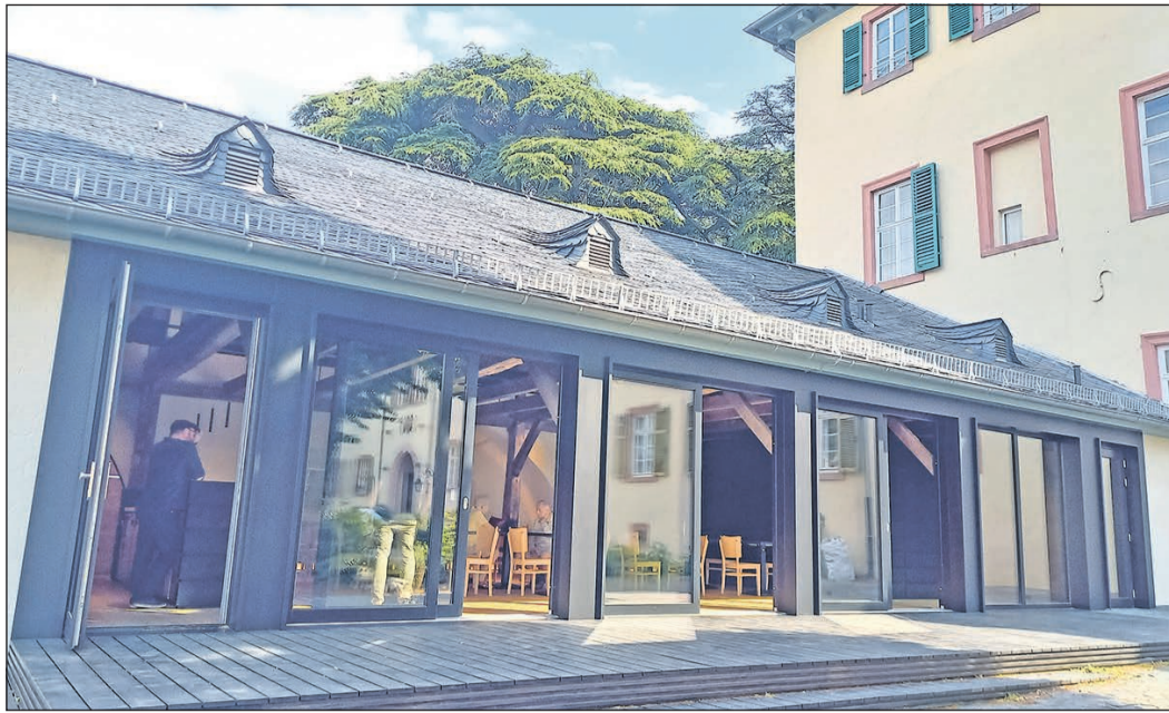
Blick auf die Glasfassade des neuen Schlosscafés im unteren Schlosshof.
