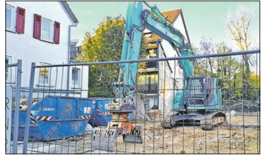
Was wird auf dem ehemaligen Windrose-Gelände gebaut? Zu dieser Frage hat Graham Tappenden für die Oberurseler Woche ein Interview geführt. Foto: gt
