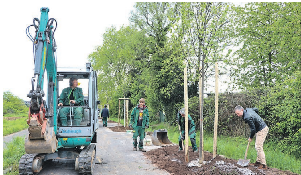
Mit Hilfe eines Baggers und per Muskelkraft werden die 21 jungen Bäume entlang der Waldstraße gesetzt. Foto: Nicole Gruber
