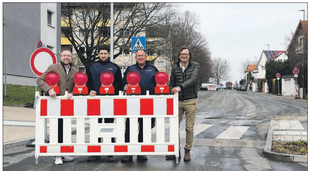
Bürgermeister Steffen Bonk, Andrej Bruch, Bauleitung Tief- und Straßenbau der Firma „Faber & Schnepf“, Mario Deiß, Polier Tief- und Straßenbau der Firma „Faber & Schnepf“ und Bauamtsleiter Alexander Müller (v. l.) begutachten die neu aufgebrachte Fahrbahndecke im Hessenring. Foto: Nicole Gruber
