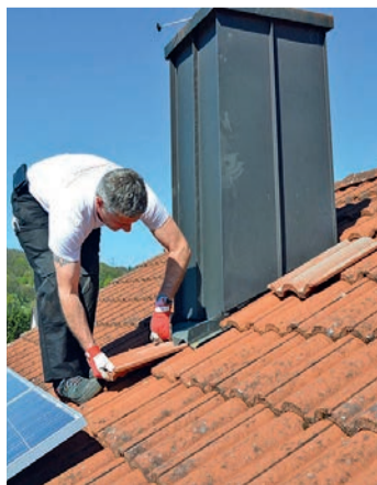
Anschlüsse an Dachdurchdringungen werden beim DachCheck begutachtet. Foto: HF Redaktion/akz-o
