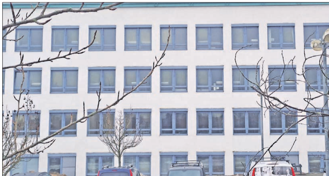
Durch die Fenster sind im hinteren Thomas-Cook-Gebäude Etagenbetten zu sehen. Foto: gt
