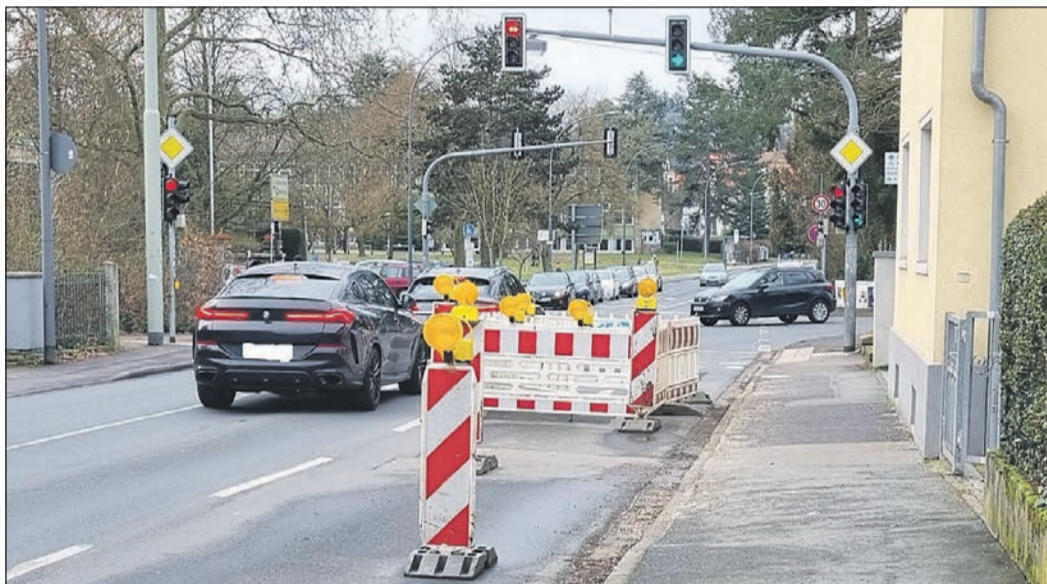
Die offene Baugrube in der Oberhöchstader Straße bleibt, in den Osterferien folgen weitere Bauarbeiten. Foto: Stadtwerke
