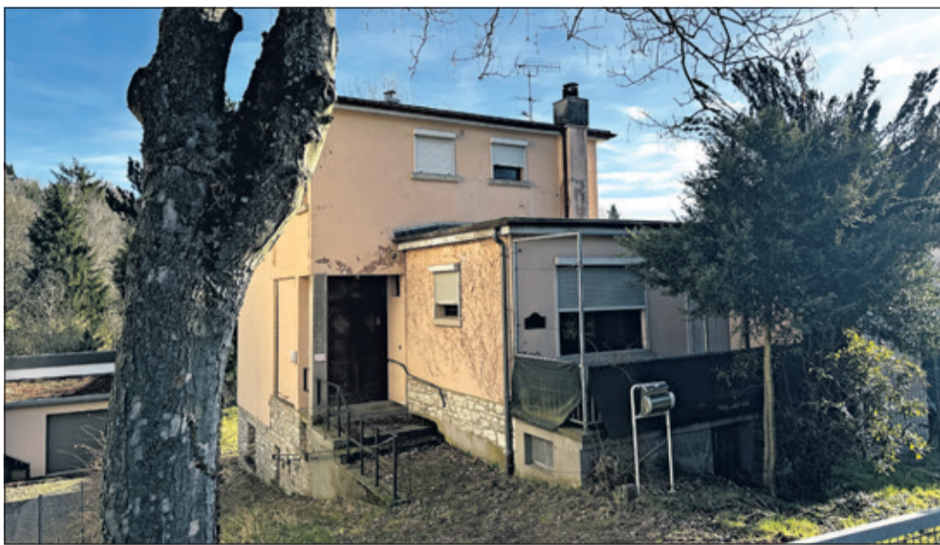
Das Fritz-Best-Haus wird nun saniert und umgebaut.
