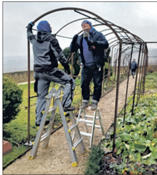
Die Demontage des Rankgerüsts durch die Firma Florschütz im unteren Prinzengarten
