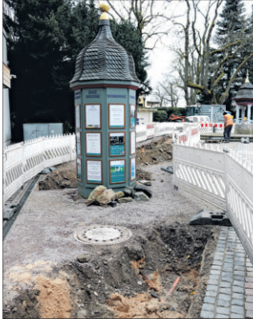
Die Bauarbeiten für den Trinkbrunnen an der KuSi sind in vollem Gange.
