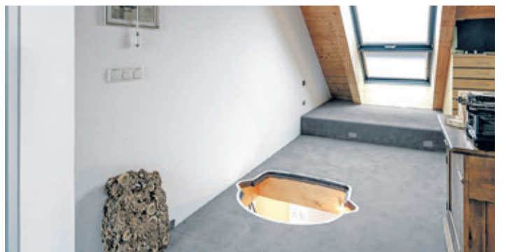
Der Einbau des Homelifts erfolgt durch die Lifton-Profis. Erforderlich sind lediglich ein Deckenausschnitt und ein herkömmlicher Stromanschluss. (Foto: epr/Lifton)
