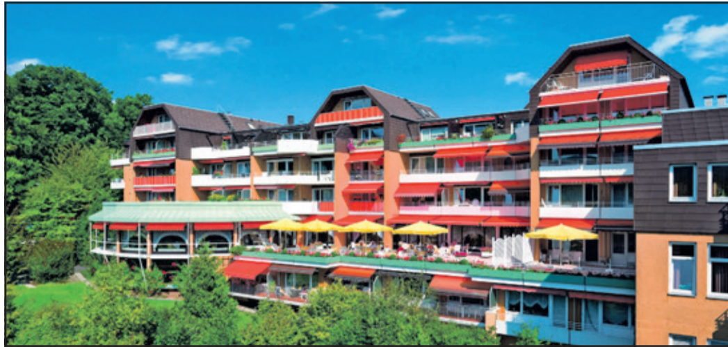
Die Seniorenwohnanlage Rosenhof in Kronberg
