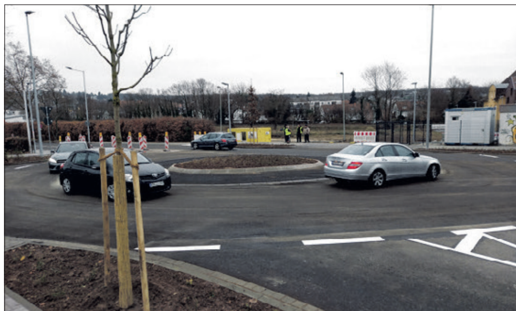
Der Verkehr rollt wieder: Der Kreisel an der Königsteiner Straße im Bereich Schubertstraße/Hasselstraße. Foto: Stadt Bad Soden
