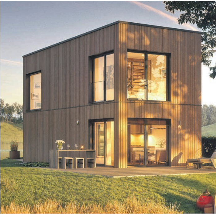
Zwei Vollgeschosse mit Flachdach vereint dieser kompakte Hausentwurf. Foto: DJD/WeberHaus
