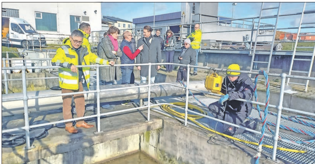
Ortsbesichtigung mit Fachleuten und Experten: OB Alexander Hetjes und Tiefbau-Fachbereichsleiter Markus Philipp (Mitte) an einem Klärbecken, in dem gerade ein Taucher in trüber brauner Mühe ohne jegliche Sicht Reparaturarbeiten durchführt. Fotos: js
