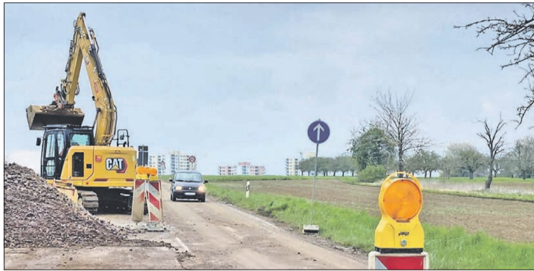
Langsam nähert sich das Ende der Baumaßnahme am Radweg zwischen Niederhöchstadt und Steinbach. Foto: Stadt Eschborn
