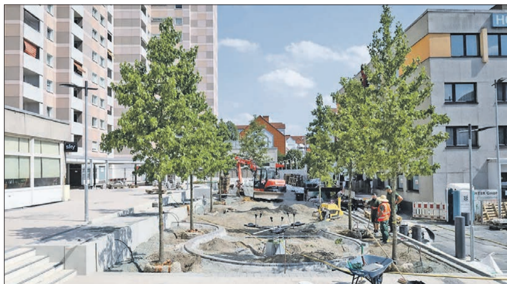
Die Fertigstellung des unteren Marktplatzes rückt näher: Hier werden sieben Amberbäume mithilfe eines Kranwagens gepflanzt. Foto: Stadt Schwalbach
