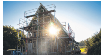
Die Fachwerkhäuser im Naturdorf Bärnau werden 2024 fertiggestellt und bezugsfertig sein.
