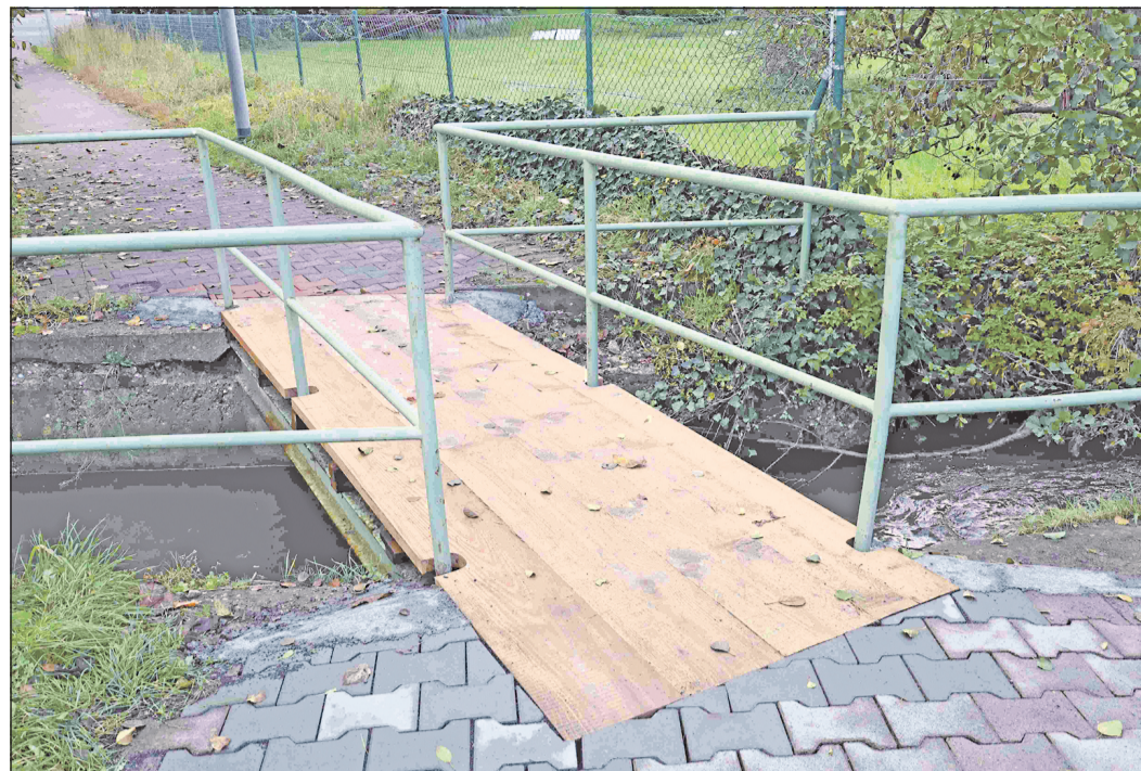
Provisorische Brücke über den Sauerbornsbach.
