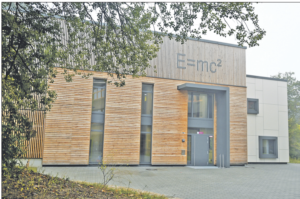
Der Erweiterungsbau der Albert-Einstein-Schule in Schwalbach.
