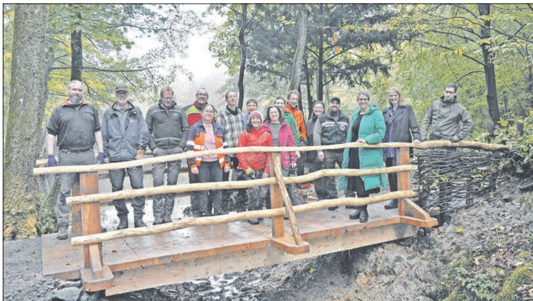
Freiwillige und Organisatoren des Projektes stehen auf der neu errichteten Brücke am Franzoseneck. Foto: Andrea Königslehner
