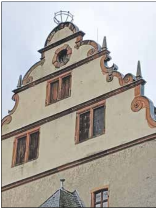
Hoch oben auf dem Dach des Kronenstammhauses befindet sich der Storchenkorb.
