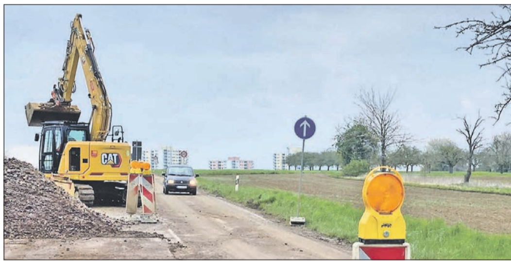
Langsam nähert sich das Ende der Baumaßnahme am Radweg zwischen Niederhöchststadt und Steinbach. Foto: Stadt Eschborn
