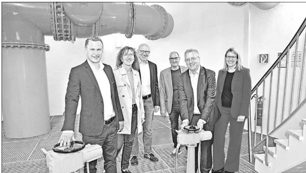
Bad Homburgs Bürgermeister Dr. Oliver Jedynek, Annegret Zirkel-Biener, der Technische Leiter der Stadtwerke Oberursel, Dieter Gredig, der Technische Direktor der Stadtwerke Bad Homburg, Markus Philipp, Christof Fink und Julia Antoni (v. l.) nehmen den erneuerten Tiefbehälter „Lange Meile“ in Bad Homburg offiziell in Betrieb. Foto: Königslehner
