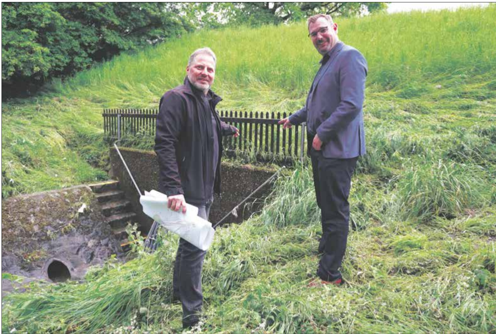
Das Rückhaltebecken in Bad Soden-Neuenhain wird ausgebaut: Christian Seitz (re.), der Vorsteher des Abwasserverbandes Main-Taunus, und Christian Hielscher, der stellvertretende technische Geschäftsführer des Verbandes. Das niedergedrückte Gras zeigt den Wasserstand im Becken nach dem letzten Starkregen an. Foto: Tocha
