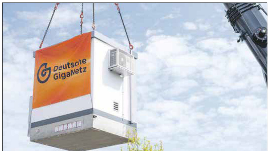
Das Glasfasernetz wird ausgebaut. Dazu werden auch Verteilstationen installiert. Foto: Gemeinde Sulzbach
